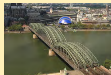
Die Hohenzollernbrücke ist immer noch das Nadelöhr für den Zugverkehr auch ins Siegtal
