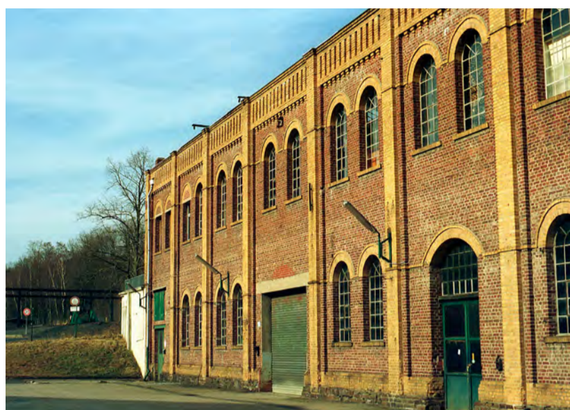
So sah die Halle noch 1997 aus. An eine neue Nutzung war noch nicht zu denken.
